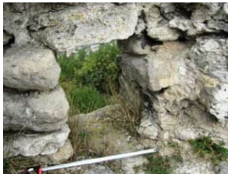
Рис. 6. Кременецький замок. Гніздо несучої балки “городні” та “обланка” у верхній частині муру
