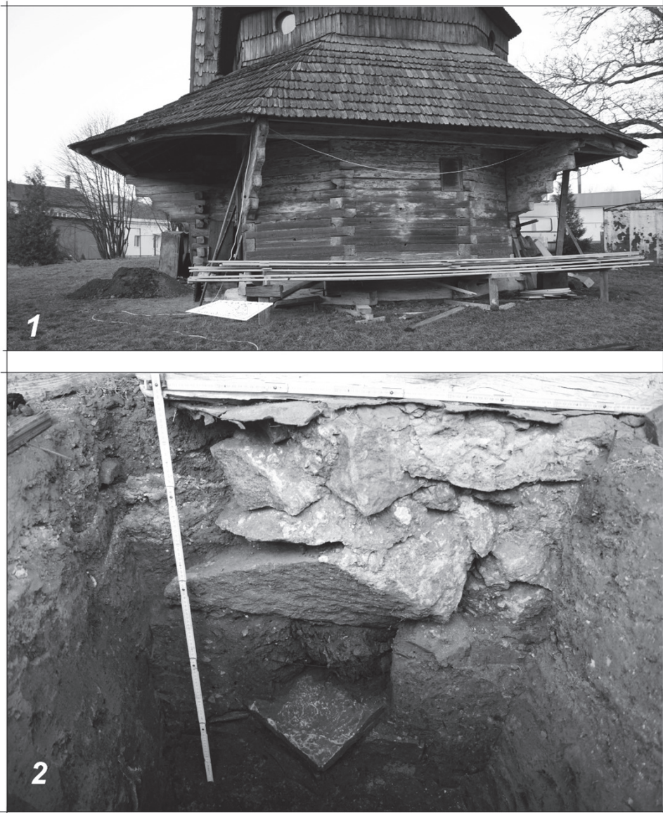
Рис. 10. Зонда 5:1 – місце розпланування зонди, вигляд зі сходу; 2 – фрагмент комбінованої муровано-дерев'яної конструкції фундаменту під вістарним зрубом, вигляд з південного сходу. (Фото автора)
