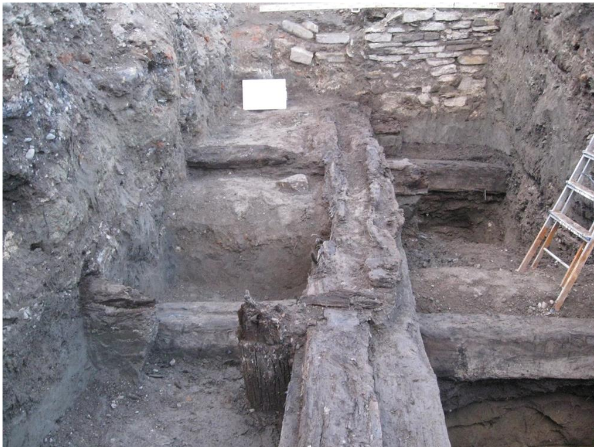
Рис. 28. Стрий, замок. Загальний вигляд на центральну частину основної масивної підвалини з брусами-лежнями, які розміщені перпендикулярно (фото в процесі розчистки споруди)
