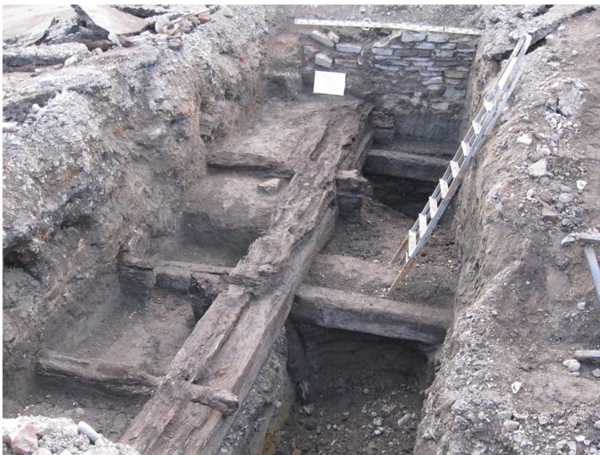
Рис. 26. Стрий, замок. Загальний вигляд на центральну частину основної масивної підвалини з брусами-лежнями, які розміщені перпендикулярно
